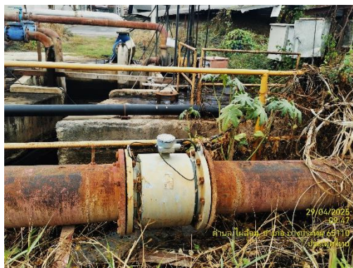
รูปที่ 30 มิเตอร์ตรวจสอบปริมาณน้ำเสีย
