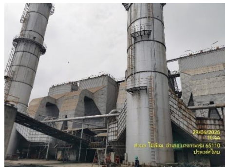
รูปที่ 24 ระบบดักฝุ่นแบบไฟฟ้าสถิตย์
