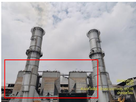
รูปที่ 24 ระบบดักฝุ่นแบบไฟฟ้าสถิตย์
